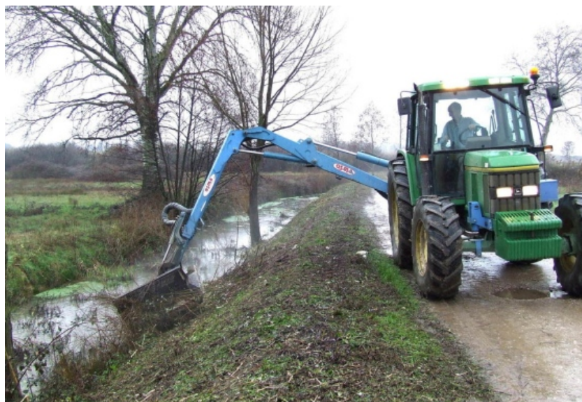
Lavori di manutenzione in un fosso
