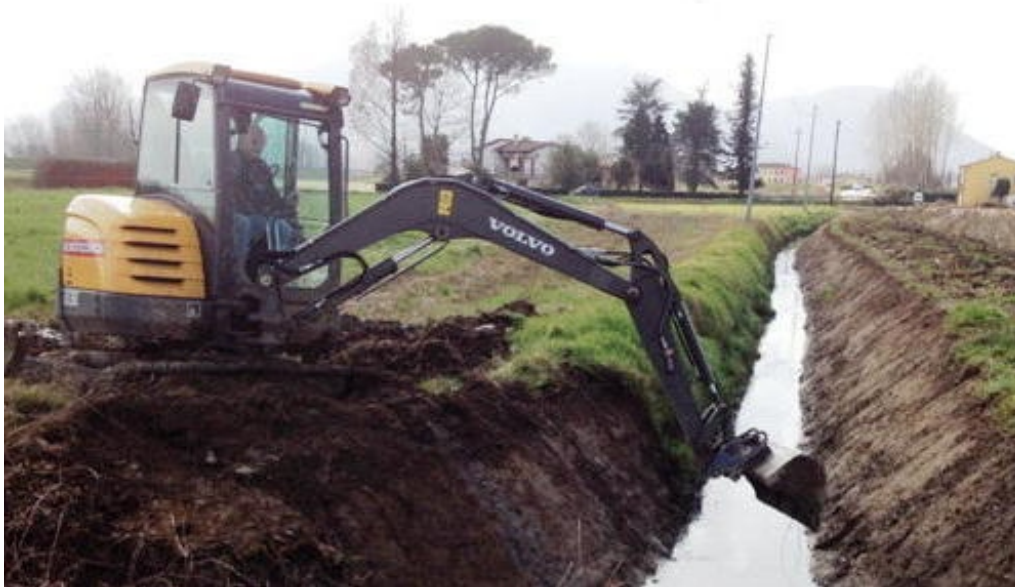
Un mezzo al lavoro per opere di bonifica (foto d'archivio)
